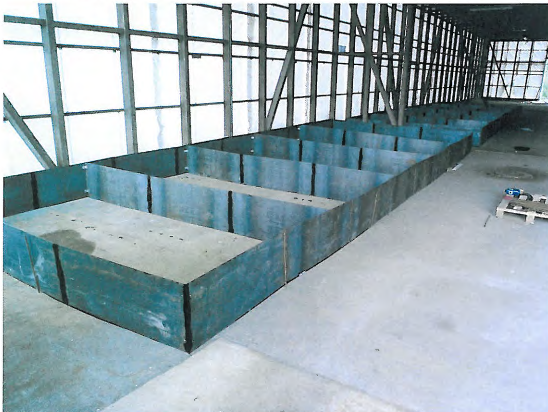
2. Metallpiirded enne pinnase sissepanemist
